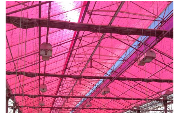
lichtdoorlatende zonnepanelen op kas; het rode licht bevordert groei
