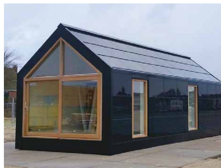
Nieuwe zwarte energieschuren, afgewerkt met zonnepanelen en/ zonnecollectoren. Te benutten voor de elektrische installaties, accu's en bijvoorbeeld de opslag van hout (biomassa) voor de kachel.
