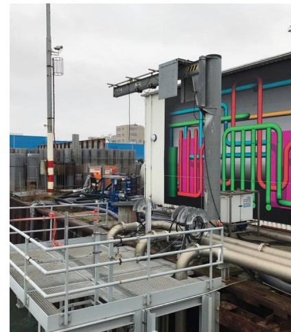
warmte uit zeewater, installatie Kijkduin
