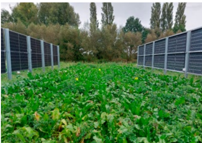
Figuur 1 Boven: rode bessen onder zonnepanelen, de zonnepanelen zijn deels transparant om ervoor te zorgen dat er voldoende licht bij het fruit komt (foto: Frank de Ruijter). Onder: verticaal geplaatste panelen, waartussen gewassen geteeld kunnen worden (foto: Thomas Reher). De panelen zijn tweezijdig (bifaciaal) en kunnen aan beide kanten stroom produceren. De rijen worden noord-zuid geplaatst en de panelen produceren dan de meeste stroom in de ochtend aan de oostzijde en in de middag aan de westzijde.
