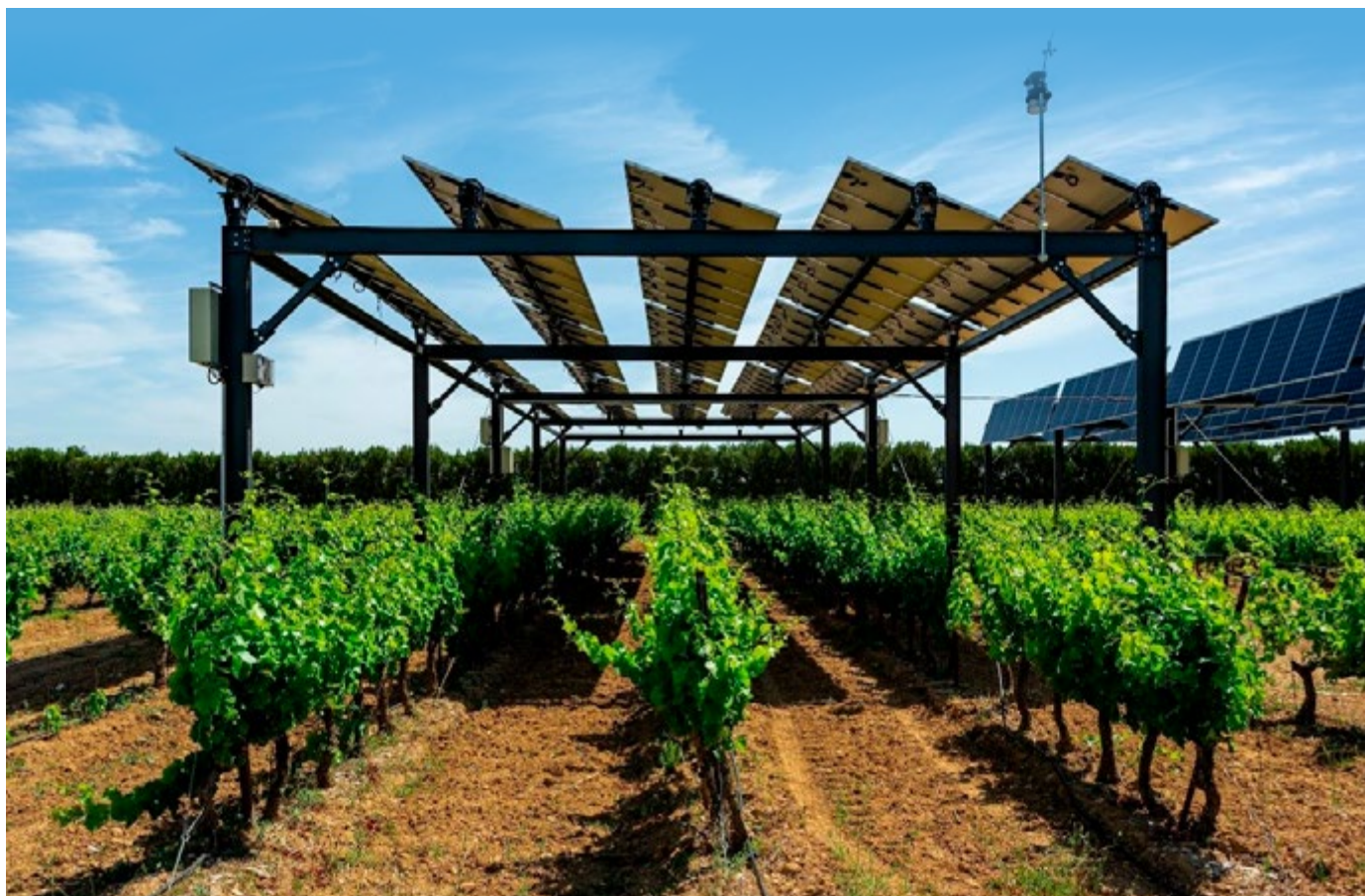
Figuur 3 Beweegbare panelen boven druiven in Piolenc, Zuid-Frankrijk (foto: Sun'Agri 8 )
