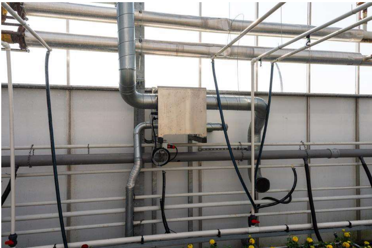
Figuur 1: De geïnstalleerde condair adsorptiedroger in afdeling 3.2 op het Delphy Improvemt centre.
